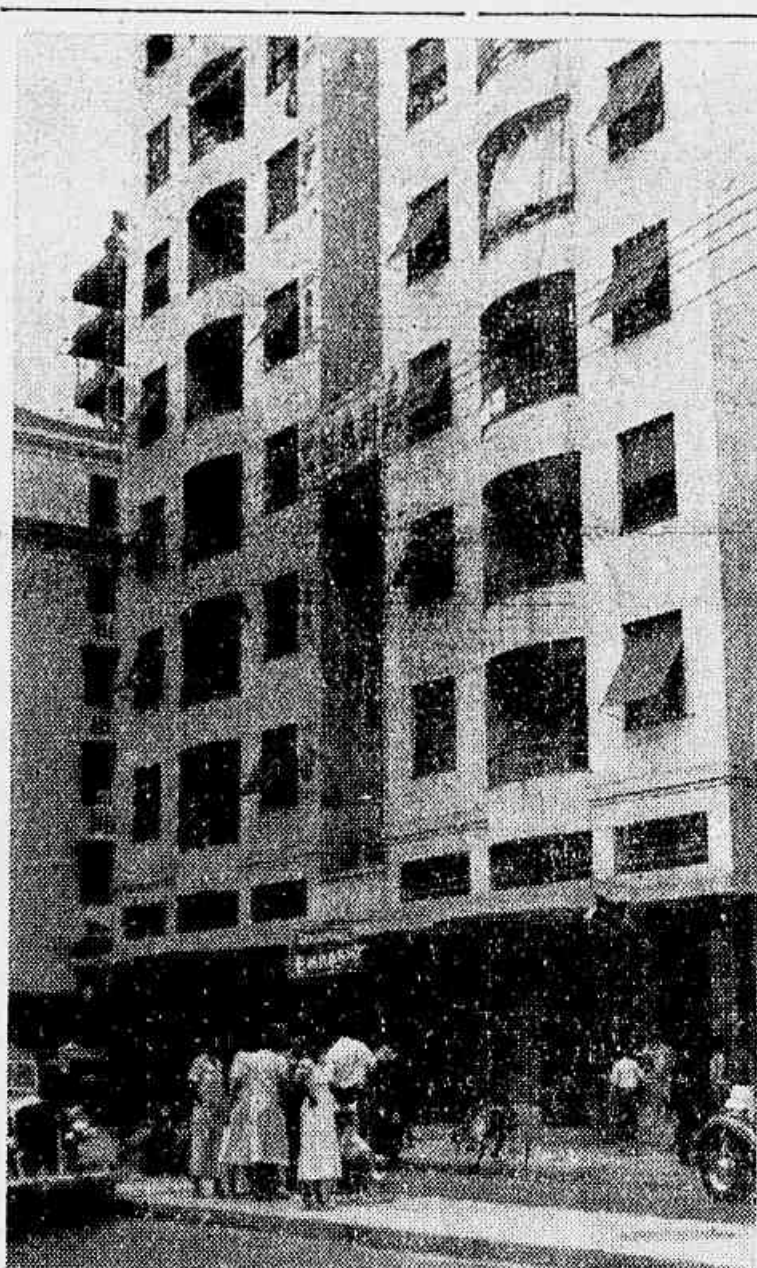
O edificio Ceará, de onde caiu, na area dos fundos, o malgrado Luiz Lastos de Oliveira
